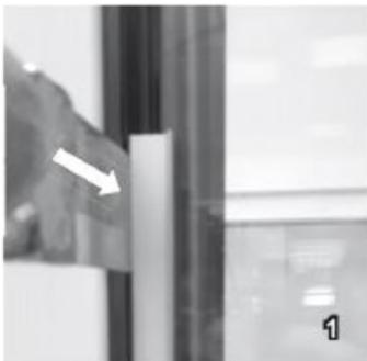
1. Nun entfernen Sie die Klipleisten. (Alu). Dazu eine Spachtel zwischen Klip- und Grundleiste einbringen.
