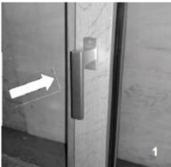
1. Fenstergriff auspacken und auf die Bohrungen aufstecken.
