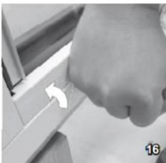
16. Nun drücken Sie die Glasleisten in die Aluleiste und mit dem Klebeband an die Glasscheibe. Mit vorsichtigem Klopfen anpressen.
