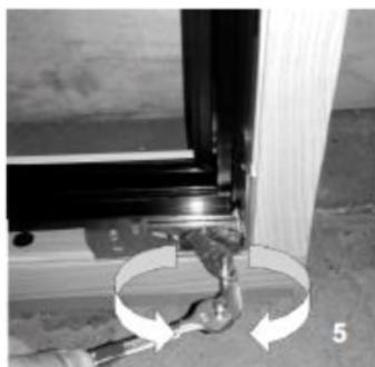
5. Anpressdruckverstellung an Exzenterbolzen am Ecklager.
