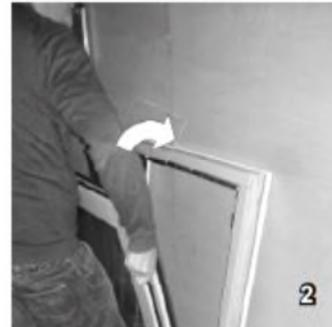
2. Den Flügel in der Kippstellung in den Bolzen des Ecklagers stellen und zum Rahmen drücken.
