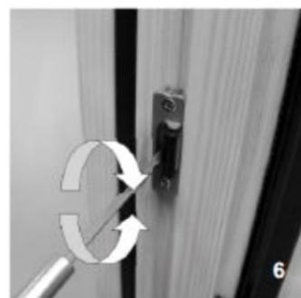
6. Anpressdruckverstellung bei der Zwangsverriegelung.
