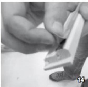
14. Das Klebeband der Glasleiste durch Entfernen der Abdeckfolie scharf machen.
