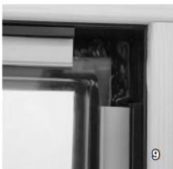
**Bei Schwerlastausführungen (alle Glasscheiben über 120kg) und RC2 die Glasscheibe umlaufend mit FIX-O-ROUND verkleben.**
