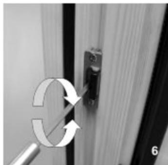
6. Anpressdruckverstellung bei der
