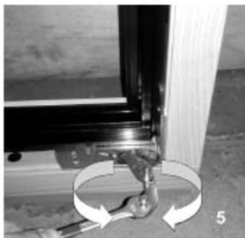
5. Anpressdruckverstellung an
